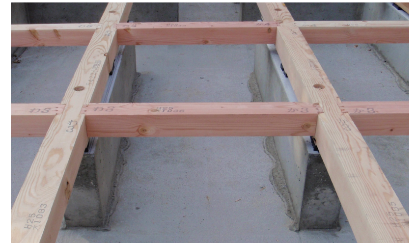
土台敷き状態
